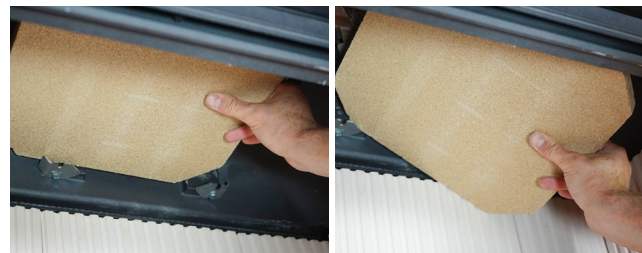
Vorgehensweise zum Entnehmen der oberen Umlenkplatte (hier: HKD 13).
