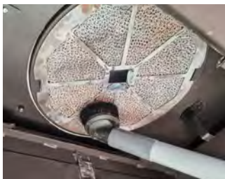
Czyszczenie katalizatora za pomocą odkurzacza i szczotki
