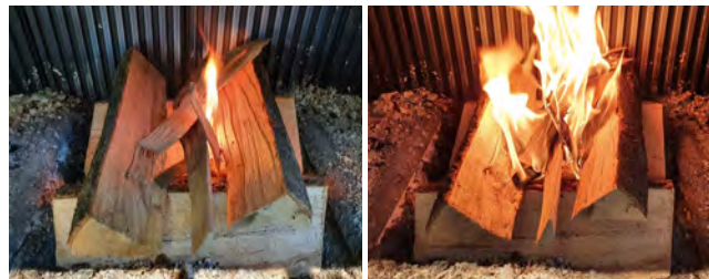
Správný proces zatápění v ohništi pomocí podpalovače a třísek uložených mezi horní vrstvou polen
