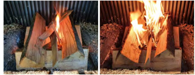
Perfekter Anzündvorgang in Feuerraummulde mit Anzündbusch und Anzündhölzern zwischen der oberen Holzlage.
