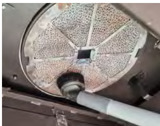
Čištění katalyzátoru vysavačem na popel s kartáčovým nástavcem
