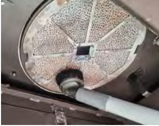
Pulizia del catalizzatore con aspiracenera e spazzola
