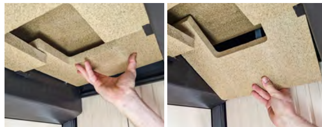
Procedura de îndepărtare a plăcilor deflectoare inferioare
