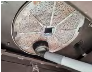
Nettoyage du catalyseur avec un aspirateur à cendres et embout à brosse
